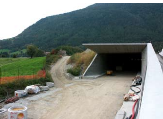
Cantiere della circonvallazione Varna
