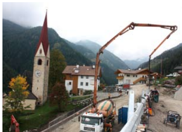
Ampliamento della strada e costruzione di un marciapiede a Scaleres
