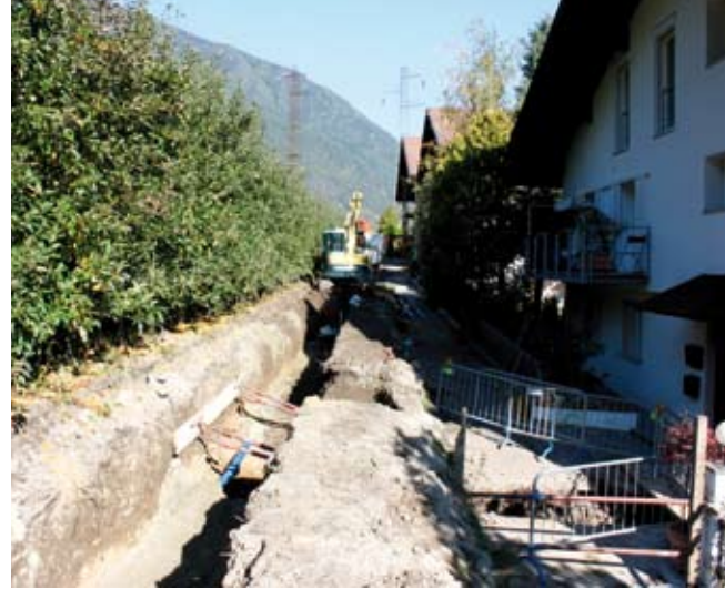
Lavori di scavo nella via Polten
